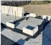
Los cimientos de la vivienda deben tener una capa impermeabilizante necesaria para una correcta elevación posterior del muro.
